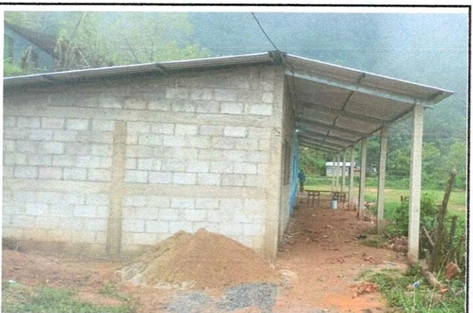
Foto 4: Reparación de losa de patio
