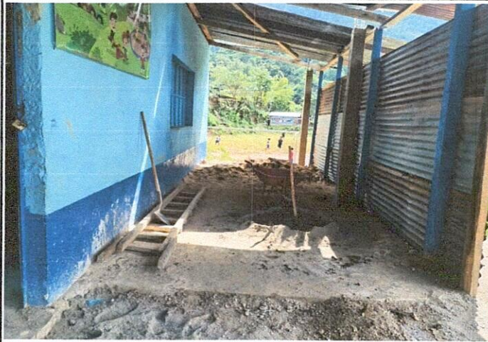
Foto 1: Reparación de losa de patio
