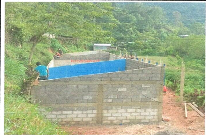
Foto 4: Remodelación de aula tipo portico
