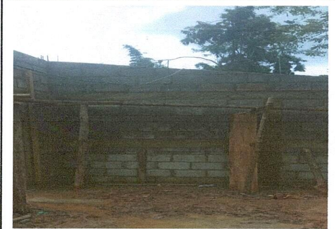
Foto 2: Remodelación de aula tipo portico
