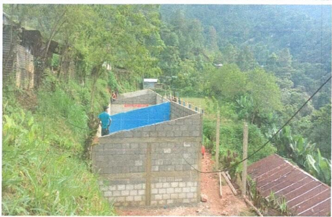
Foto 3: Remodelación de aula tipo portico
